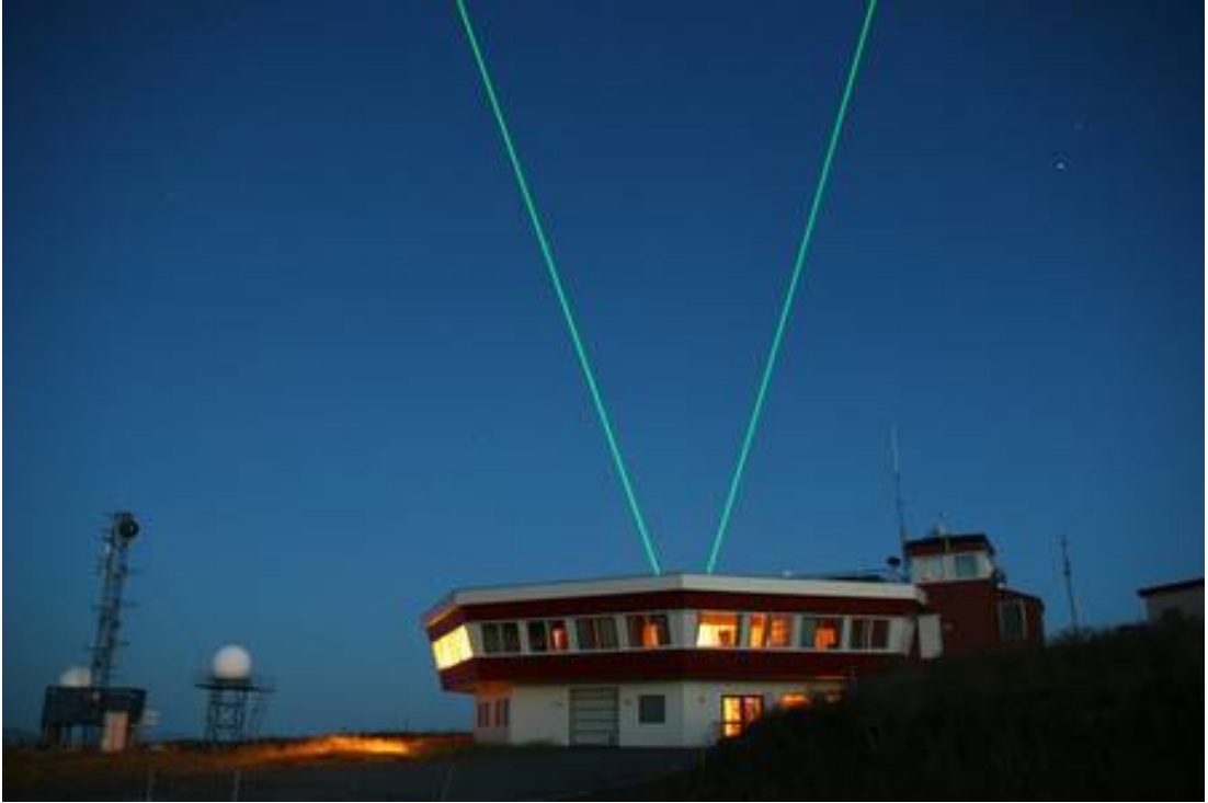
Abbildung 2.1: ALOMAR-Observatorium mit den beiden grünen Laserstrahlen des RMR-Lidars [2]
