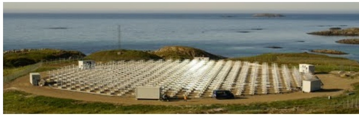
Abbildung 1.6: Maarsy-Radar in Andøya (Phased Array Antenna). nach rezn8d.com (MAARSY. Andøya, Norway 800 kW - 53.5MHz)
