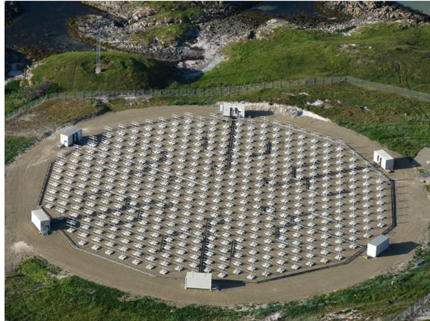
**Abb. 2.5:** Foto des MAARSY-Radars. Zu erkennen sind sechs Container, in denen die Technik untergebracht ist. Auf dem Radarfeld sind die Einzelantennen und die Kabelstränge, die die Antennen mit den Containern verbinden, zu sehen. Foto: Toralf Renkwitz
