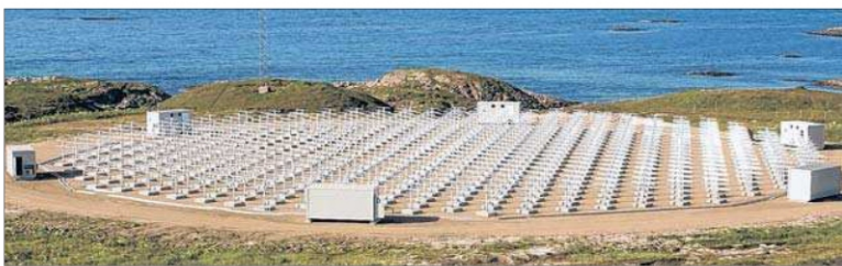
100 Meter im Durchmesser, 440 einzelne Antennen, jede einzeln steuerbar: Das große Radarfeld in Norwegen liefert weltweit bisher die einzigen dreidimensionalen Bilder von Radarmessungen. Markus Rapp ist der geistige Vater der in der Welt größten und modernsten Anlage dieser Art.
