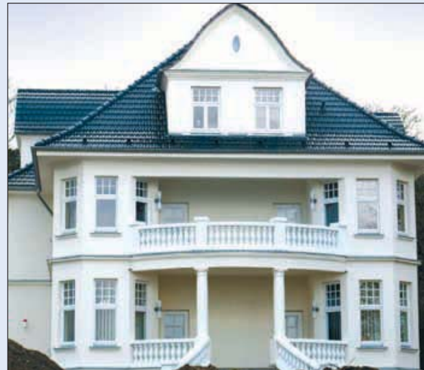
Fertig sanierte Villa von der Nordseite
