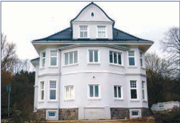
Die vor 1933 errichtete Villa, hier vor der jetzigen Sanierung
