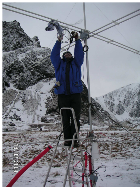
Abb. 22.4: Reparatur einer SKiYMET-Empfangsantenne
