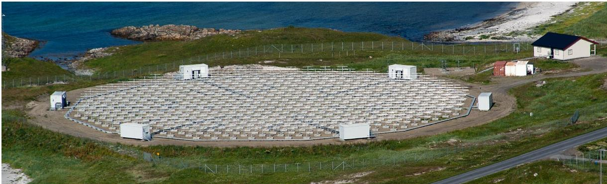
**Abb. 18.1:** Der Blick auf das MAARSY-Gelände im Juli 2011 zeigt das Antennenfeld mit den sechs Sende-Containern sowie das Hauptgebäude, in dem Radarsteuerung und Datenerfassung untergebracht sind.
