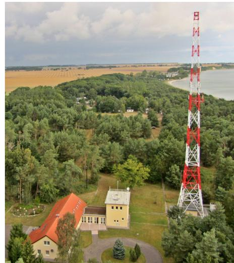
**Abb. 18.8:** IAP-Außenstelle Juliusruh mit dem 70m-Gittermast als Träger der Ionosonden-Sendeantenne
