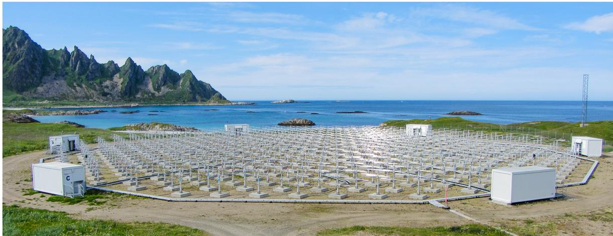
**Abb. 18.3:** Blick auf das Antennenfeld des VHF-Radars MAARSY auf Andøya. Die 433 Sende-Empfangsmodule sind in 6 Containern am Rande des Antennenfeldes untergebracht.
