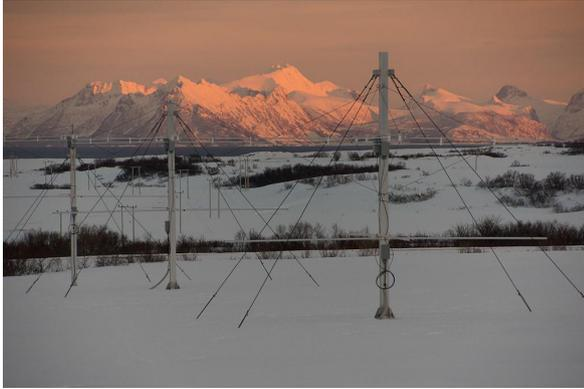
**Abb. 18.7:** Kreuz-Yagi-Antennen des Meteorradars auf Andøya. Die harten Witterungsbedingungen in Norwegen erfordern eine besonders stabile Bauform.
