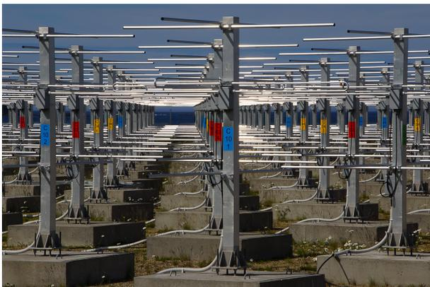
**Abb. 18.4:** Mit dem Abschluss der Erweiterung im Herbst 2013 ist das MAARSY-Antennenfeld nun komplett aus Kreuz-Yagi-Antennen aufgebaut.
