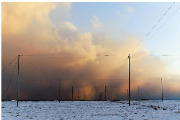
**Abb. 18.6:** Kreuzdipole des 500 Meter langen Ost-Arms der Mills-Cross-Antenne des Saura-MF-Radars auf Andøya
