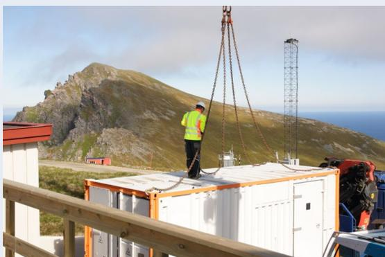
**Abb. 10:** Der Aufbau des mobilen Fe-Lidars am ALOMAR-Observatorium
