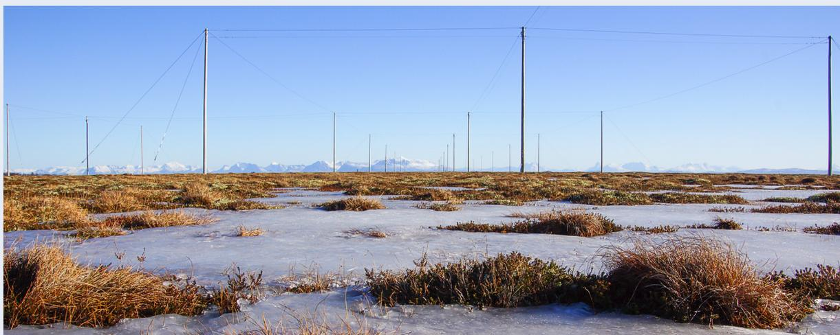
Das Saura-Radar auf der Insel Andøya ermöglicht als einziges MF-Radar weltweit das elektronische Schwenken des Radarstrahls. Aus den Messungen werden das horizontale und vertikale Windfeld sowie Elektronendichten abgeleitet.
